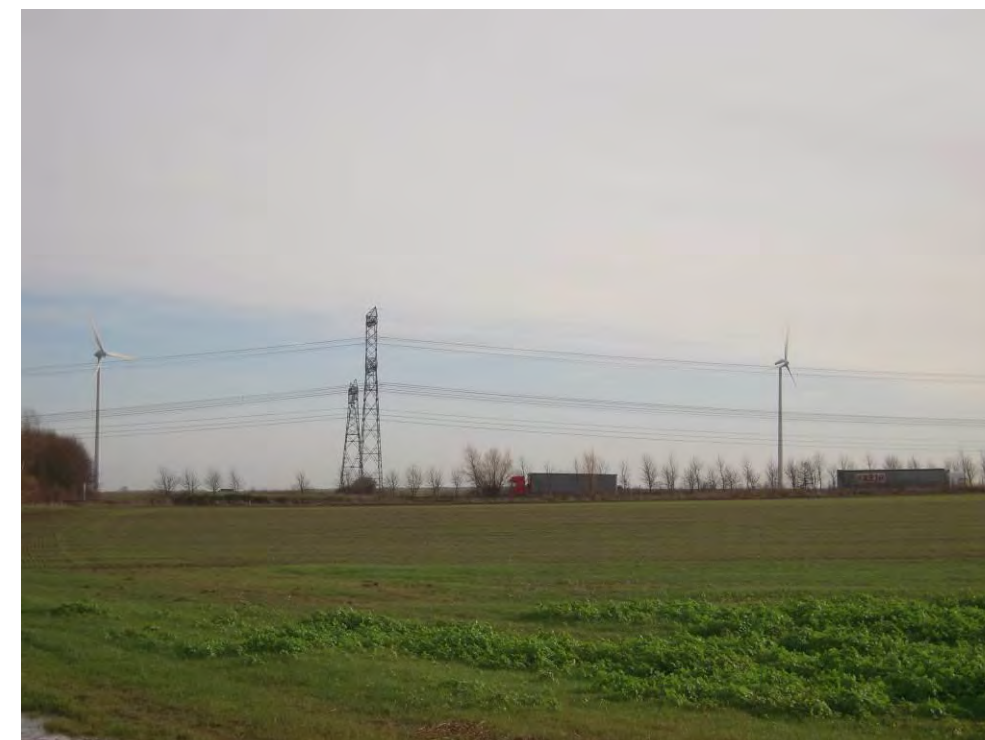
Photographie 17. A16, réseau RTE et éoliennes d'Oresmaux 1
