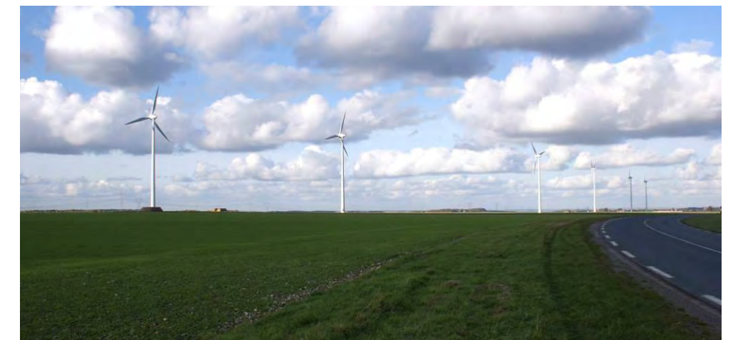
Photographie 18.RD1001 et Parc éolien d'Oresmaux
