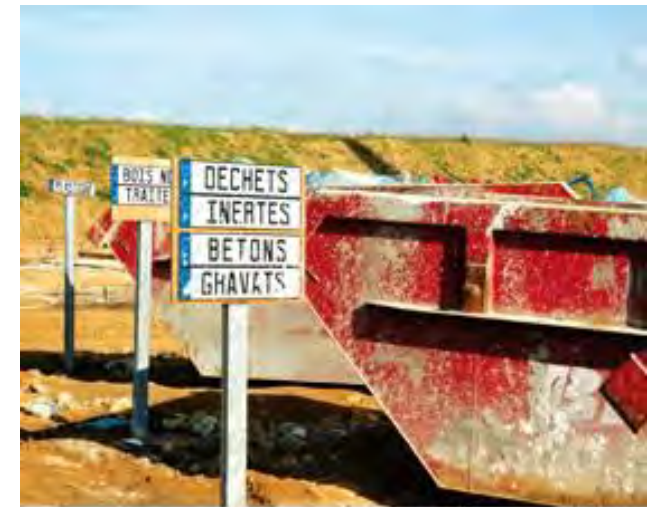
Photographie 51. Benne sur un chantier (Source : www.ademe.fr/)
