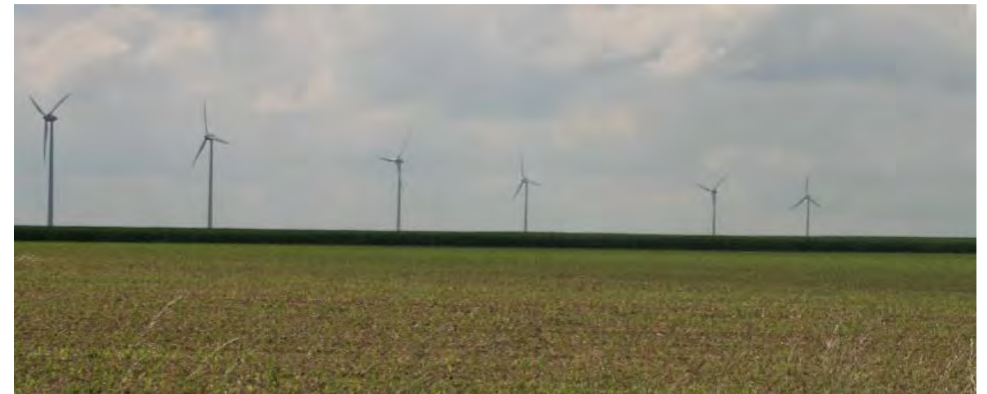
Photographie 3. Parc éolien en fonctionnement d'Oresmaux-Essertaux
