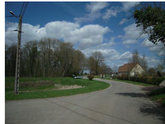
Photographie 53. Mare à réhabiliter
