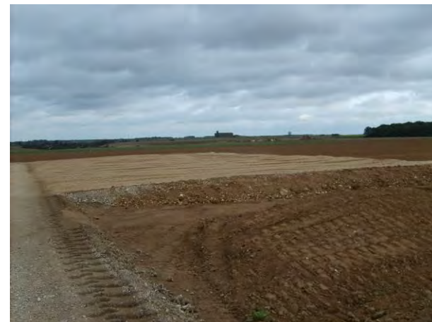
Photographie 25. Réalisation d'une plate-forme de montage
