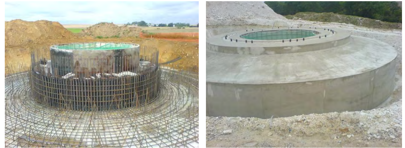
Photographie 6. Fondations d'une éolienne (Source : Enertrag)
