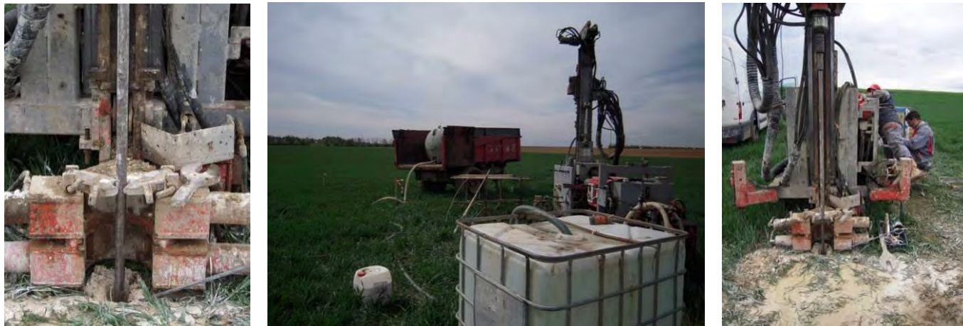
Photographie 5. Campagne de reconnaissance géotechnique (Source : Enertrag - Chantier éolien de Campremy-Bonvillers - Oise)
