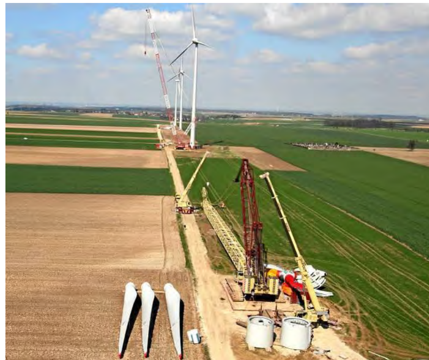
Photographie 23. Construction du parc Oresmaux 1 en 2006
