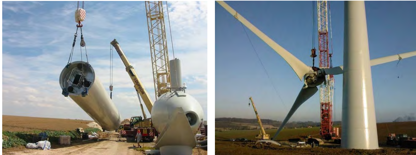
Photographie 9. Assemblage d'une éolienne (Source : Enertrag)
